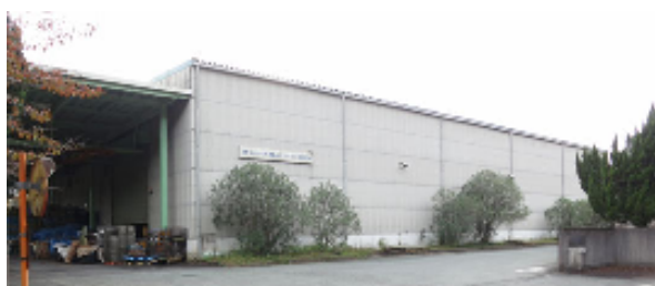
図表 8. 14 横浜機工テクノ本社
