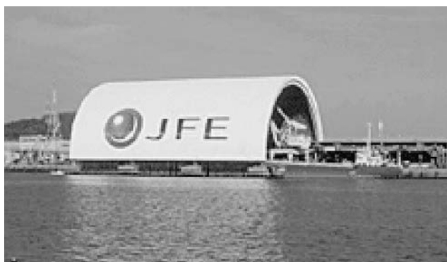
雨天荷役ドーム（映像：JFEスチール(株)提供）
